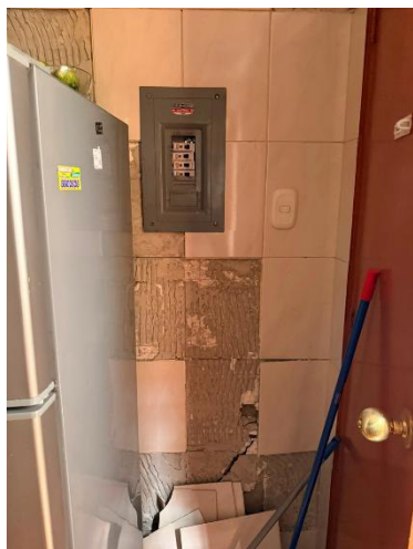
Imagen 32. Machón en ladrillo junto a columna
