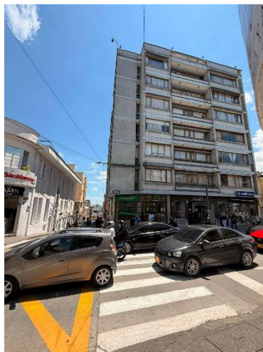
Imagen 11. Fachada edificio por carrera 22
