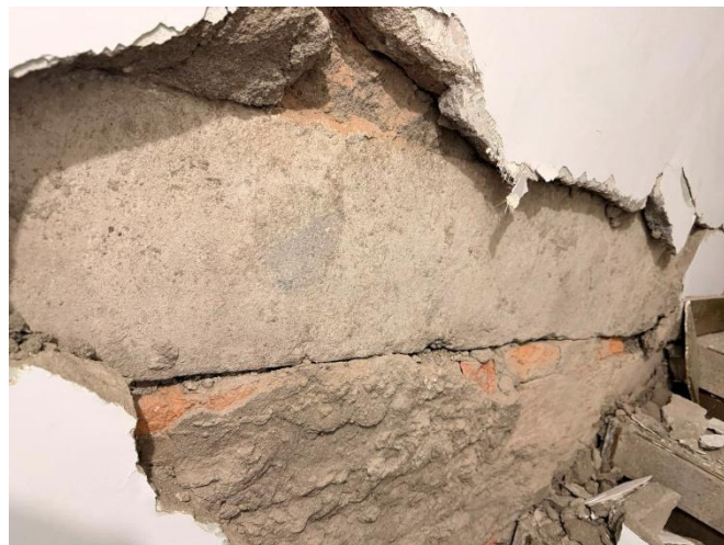
Imagen 19. Muro lateral escalera de circulación
