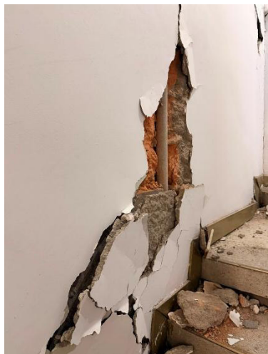
Imagen 18. Muro lateral escalera circulación
