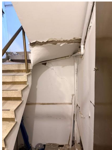
Imagen 28. Escalera de circulación y muros
