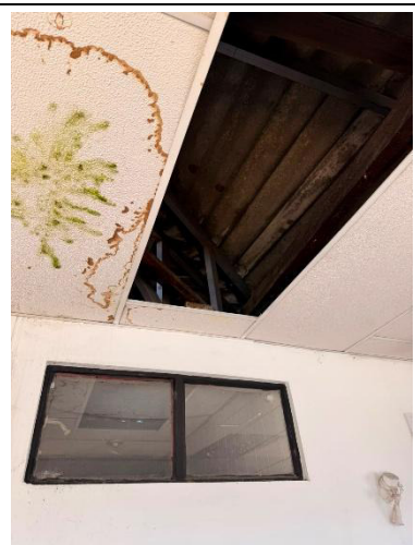
Imagen 49. Muro afectado séptimo piso
