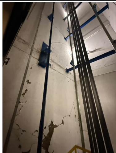
Imagen 16. Muros de cerramiento foso ascensor
