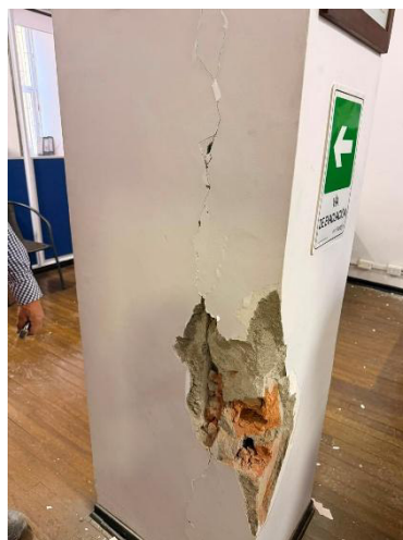
Imagen 33. Machón en ladrillo junto a columna
