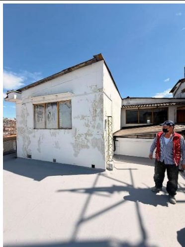
Imagen 54. Nivel de cubierta
