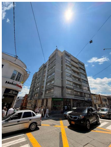
Imagen 10. Vista panorámica Edificio
