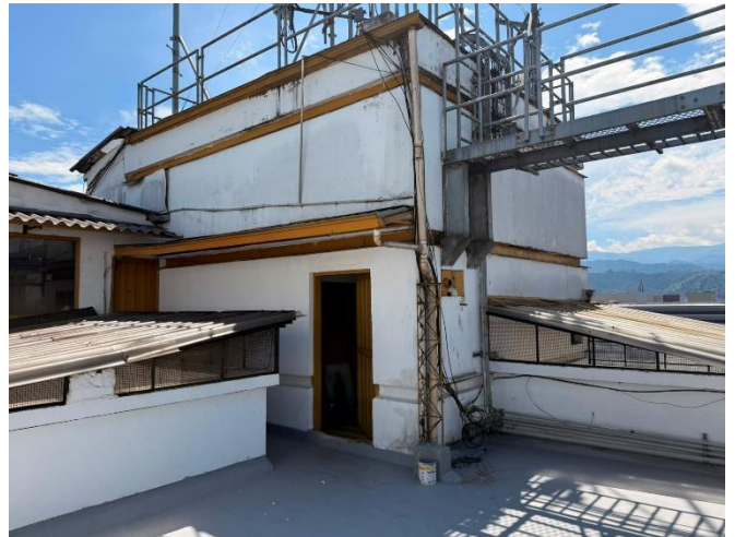
Imagen 53. Nivel de cubierta
