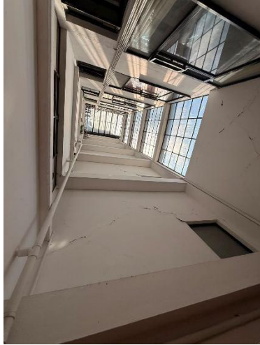
Imagen 20. Patio o cubo de luces y ventilación
