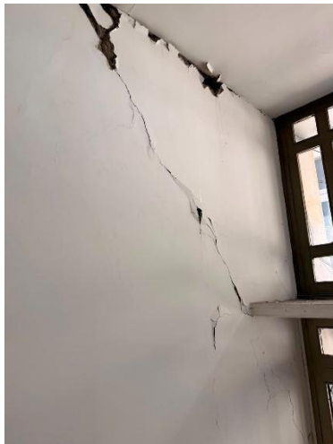
Imagen 24. Muro lateral escalera de acceso
