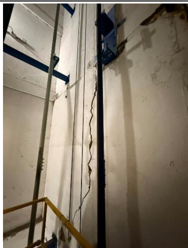
Imagen 14. Muros de cerramiento foso ascensor
