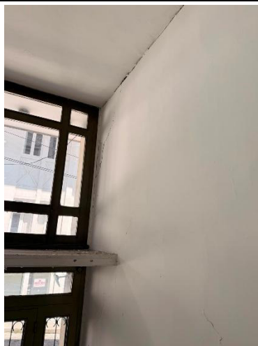
Imagen 17. Muro lateral escalera de acceso
